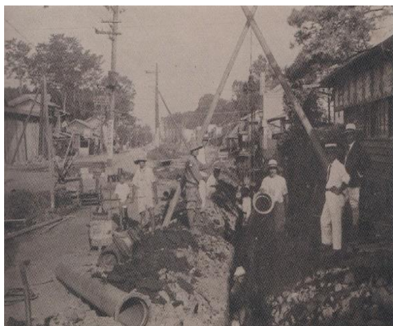
道路工事に追隨して水道管の敷設工事
