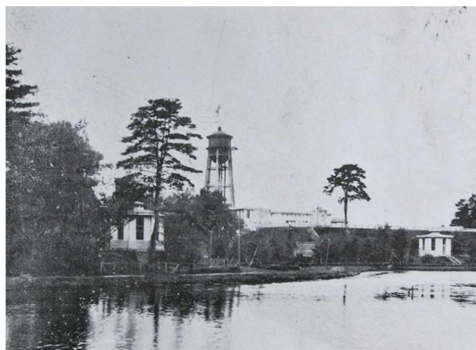
町営水道のポンプ棟と給水塔。「夏は冷たく、冬は暖かい水」は荻窪の自慢になった。
