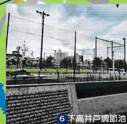
6 下高井戸調節池
